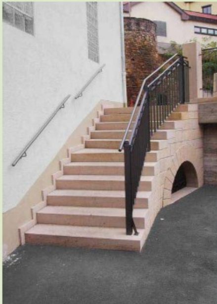
Entlang der hier unterirdisch verlaufenden Isenach wurden die Geländer erneuert und eine Treppe angelegt.
