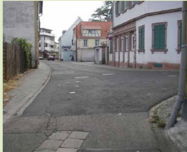
vor der Erneuerung
